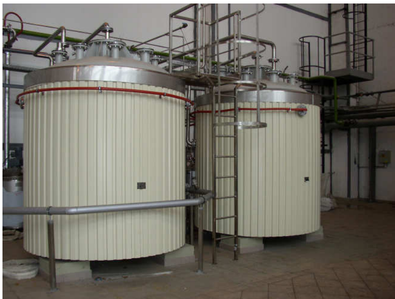
1.kép É-pesti fél-üzemi ( 2 \times 6 \text{ m}^3 ) rothasztó berendezések
